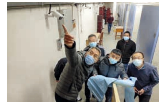
育才消防施工现场
