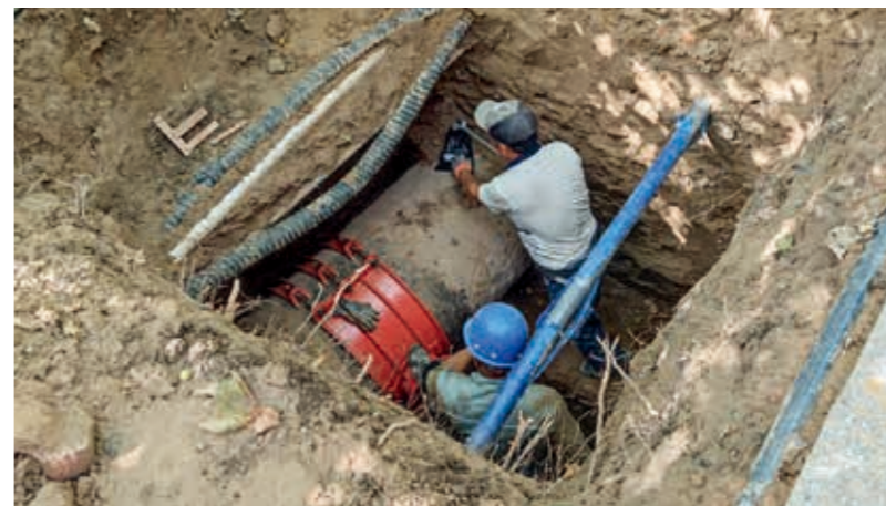
消防给水工程施工现场
