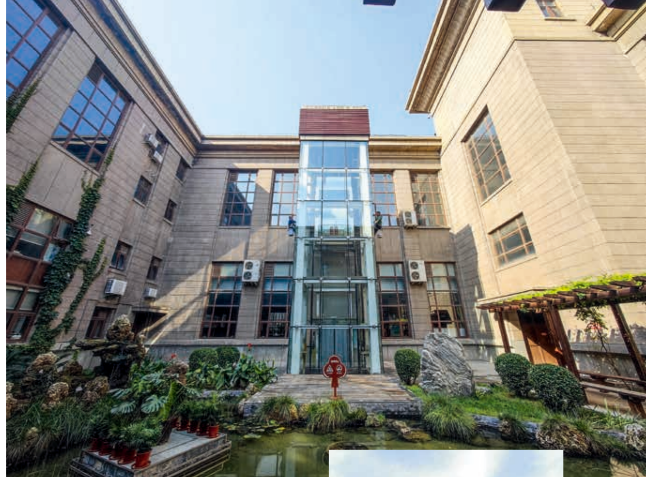
北区东天井观光电梯清洗作业
