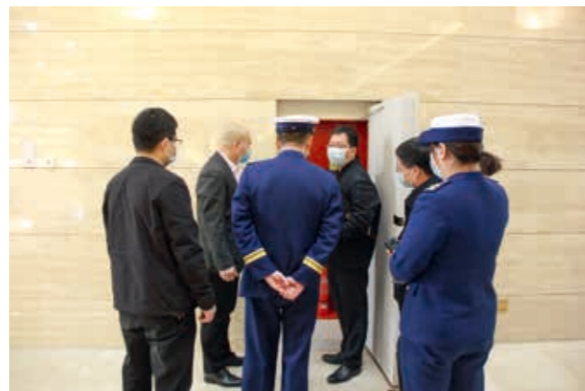
巡查组抽查公共区域 1F-062 消防栓
