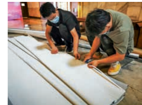
展厅遮光幕布维修
