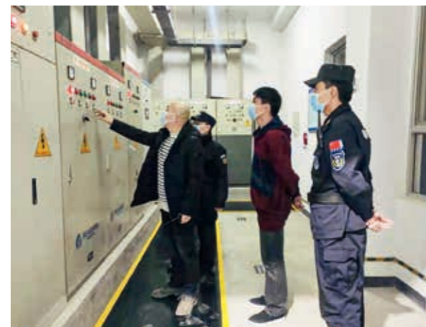
检查消防设施运行情况
