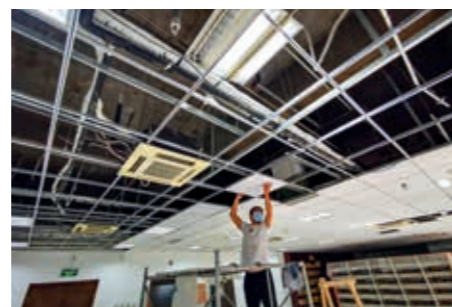
图书资料室施工现场
